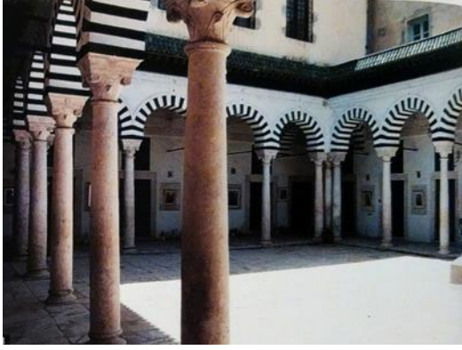
صورة (18) تونس، بلدة Medina of Tunisia المداخل المقنطرة Archway تقوم بدور التظليل وتخفيف من حدة اشعة الشمس والوقاية في الايام الممطرة (عمارة الظل) حول فناء داخلي هو قلب المسكن وجميع العناصر تلتف حوله وتجذب له ويحوى الانشطة الحيوية ويقوم على الاتصال بين الغرف وافراد العائلة.
