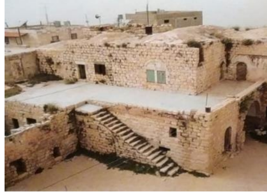
صورة (19) نموذج لمسكن اساسي تقليدي ريفي ذو ساحة courtyard لعائلة كبيرة في فلسطين، المسكن ذو تخطيط عضوي.
