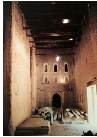
صورة (21) تونس، بلدة Tozeur, Djerid، بيت الزعيم، تصميمه موروث مشهور في منطقة البحر المتوسط، حيث ارتفاع السقف 6م لمسكن ضيقة (2.5م*3م) حل غريب لكنه يضمن راحة حرارية كبيرة، مع عقود حائطية diaphragm segmental arches تخلق مساحات داخلية واسعة، والعقد الكبير الممشوق يضفي تهذيب وجمال للفراغ الداخلي.
