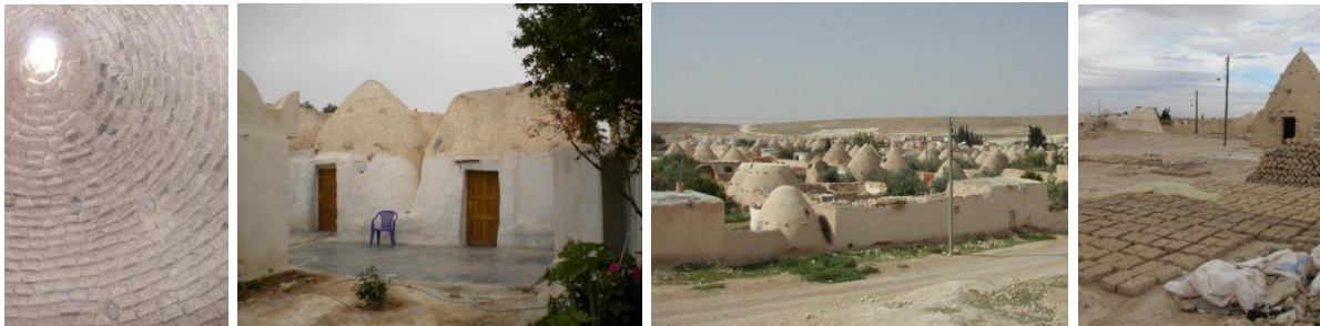
صورة (14) عمارة الظل بمساكن قرية الشيخ هلال بسوريا، استخدام الطوب الطيني في البناء واستخدام القبة في بناء هيكل السقف
